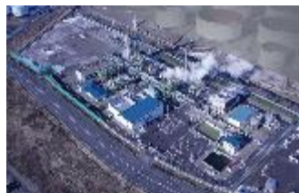
CO2分離・回収・貯留施設
