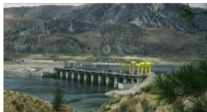
水力による水素製造施設
